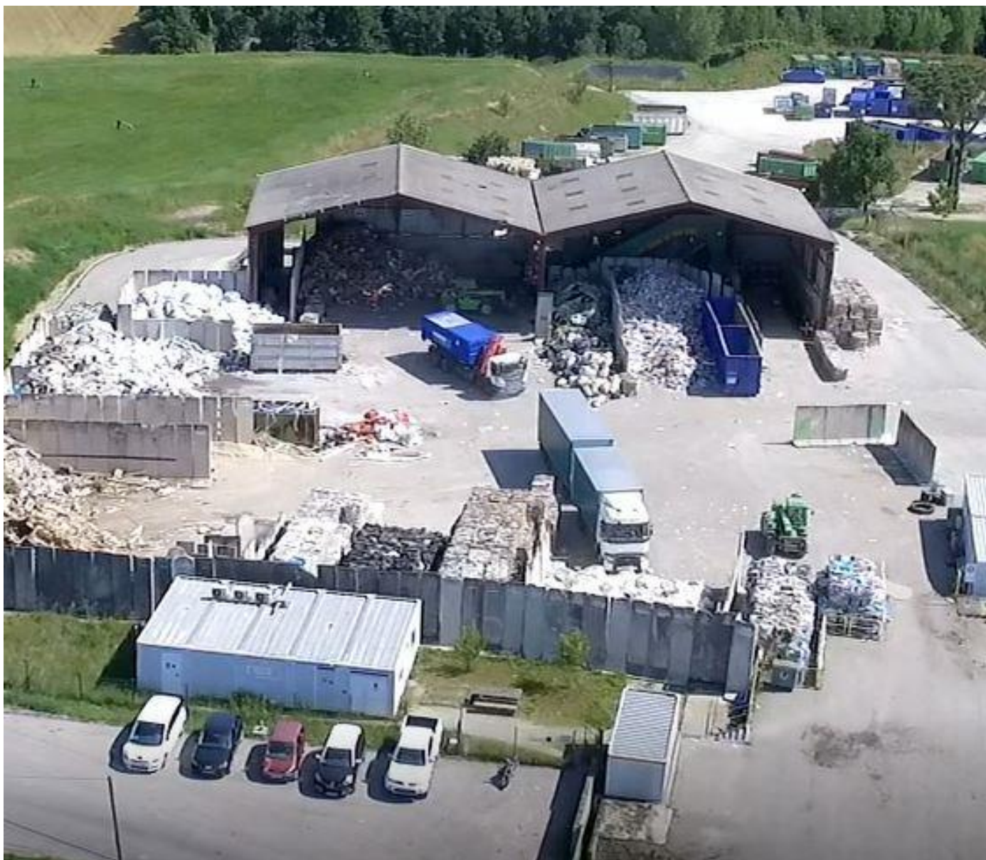
Centre de collecte et de tri des déchets professionnels de MONTAUTY - ST SULPICE
